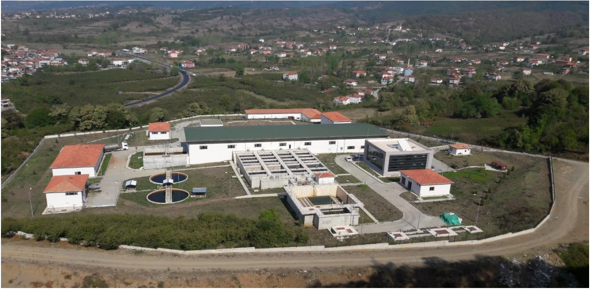
Kdz. Ereğli İçme Suyu Arıtma Tesisi
